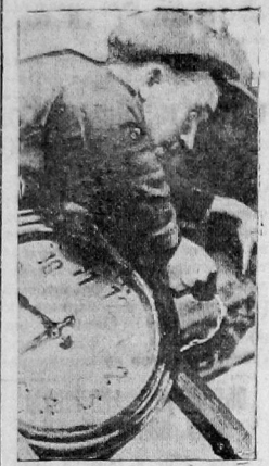
Ударник тов. Курбатов устанавливает электрочасы в цехе паровозного завода
