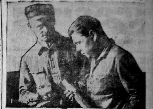
Инструментальщики паровоз-ремонтного завода и слесари ударников транспорта осматривают производство пневматических молотков. На снимке — бригадир Андрей и Рогозин за сборкой молотка
