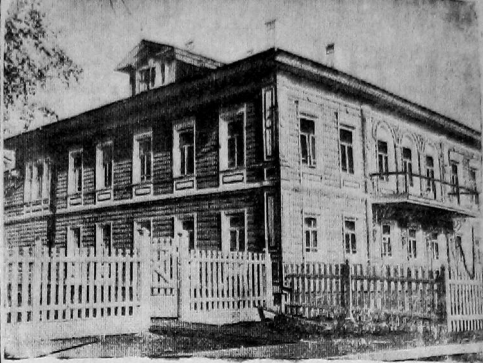
Начался ремонт помещения. И сейчас перед нами образцово отремонтированное помещение на 4 класса. Школьники будут сидеть на новых красивых и удобных партах, в чистых и уютных классных комнатах
