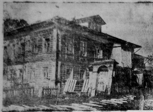
Валод «Северный коммунар» вынужден открыть свою начальную школу. Для этого был куплен полуразрушенный дом, находящийся около завода. Перелом 1 сентября сюда пришли плотники, столяры, маляры... (См. фото слева)
