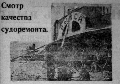
На этом пароходе, почти готовом к выходу на воду, еще до сих пор не вставлены дымгарные трубы.
