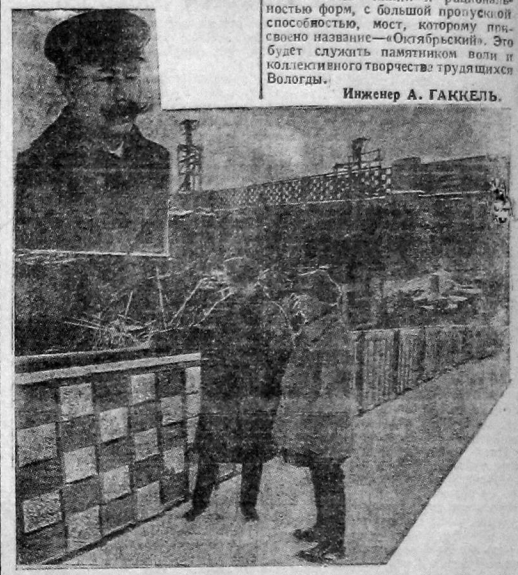
НА СНИМКЕ: сверху — строитель Октябрьского моста инженер А. А. ГАККЕЛЬ; в середине — мост после снятия тельяков. Внизу на снимке: пом. строителя инженер тов. ЗАБРОДИН бригадиром тов. КОЧЕШКОВИМ осматривают перед сдачей туртуры и чугунную решетку перила моста, изготовленную на заводах «Северный Коммунар» и ВРЗ.
