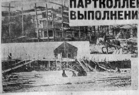
На стройке затора. Вверху на снимке: здание ФЗУ водников; внизу стройка жилых домов и мастерских.
