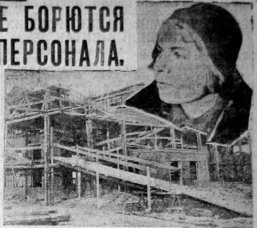
Общий вид стройки канифольного завода. Вверху инструктор крайкома промсоюза тов. ФЕТИСОВА облепующая стройку завода.
