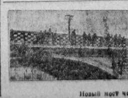
Новый мост через реку Вологод.
