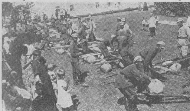
Воинские части готовят понтонный мост для переправы через р. Вологду.
