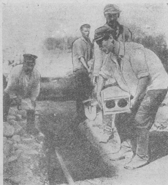
Прокладка новой кабельной телефонной сети в г. Вологде.
