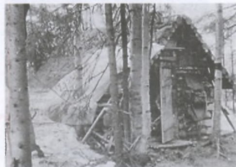
«Шалаш» при достройке (еще без покрытия пленкой и рубероидом). Внизу слева — снег
