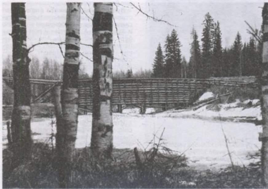
Мост через реку Илеза был сложен клетью из огромных бревен
