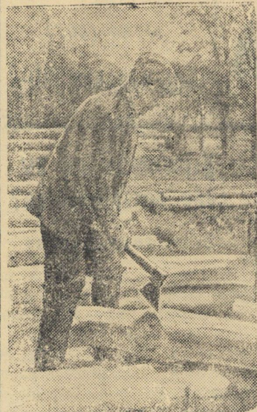
Колхозник деревни Редькино Я. Г. Захаров строит новую избу.
