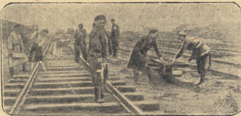
Бригада Г. И. Морочкина за ремонтом пути.
