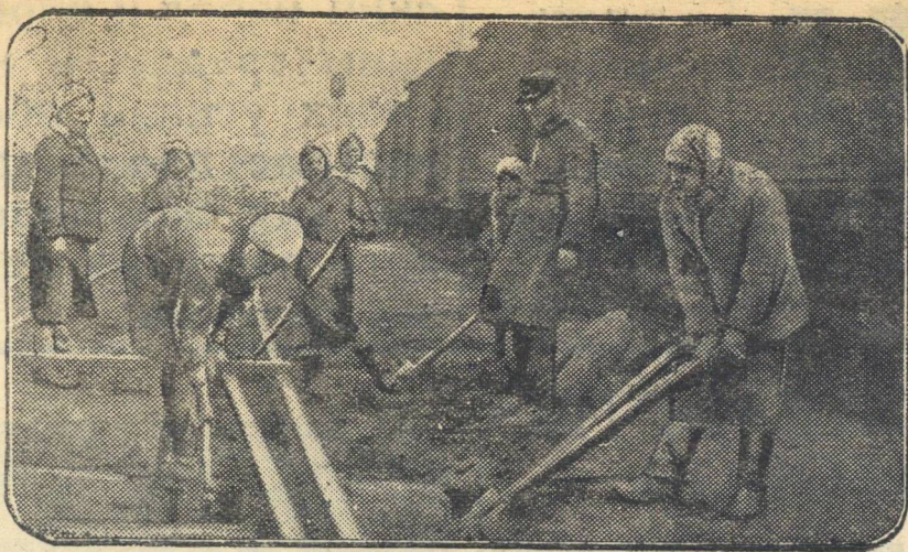
Ремонт стрелочного перевода на станции Вологда-1.
