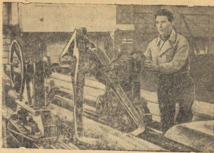
Техник-рационализатор лесопильного завода имени Куйбышева (Сталинград) тов. А. М. Егоров, сконструировавший портативную комлевую тележку для подачи бревен к лесопильной раме. Годовая экономия от одной тележки составляет 26 тысяч рублей. Фото А. Маклецова.
