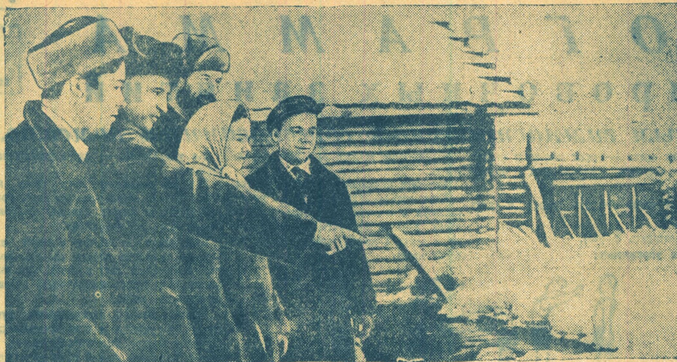
По инициативе учителя Каменской начальной школы В. А. Казарина колхозники сельхозартеля «Перелом» Лужского района построили гидроэлектростанцию. Большую помощь в строительстве оказали комсомольцы. НА СНИМКЕ: В. А. Казарин (второй слева) показывает колхозникам плотину электростанции, (справа) колхозный электромонтер — комсомолец Бана Заварин.
