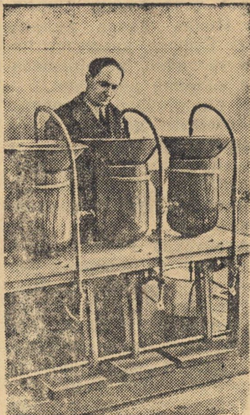
Тов. Пескин проверяет работу установки.
