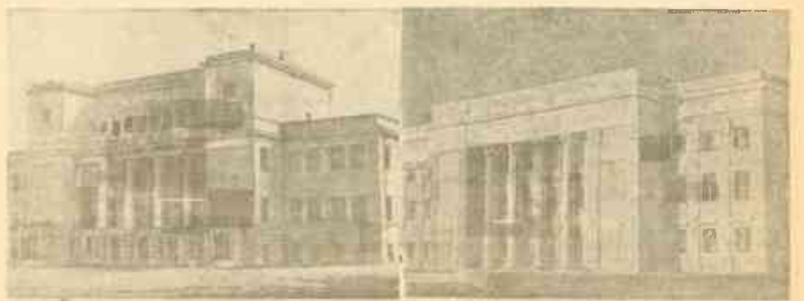
На снимке: (слева направо) Новый клуб, построенный в рабочем поселке на станции Кочетовка Ленинской железной дороги и новый Дом культуры, открытый в Ветском целлюлозно-бумажном комбинате (Карело-Финская ССР). Фото И. Великинова и Я. Роскина.
