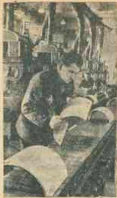
За годы сталинских пятилеток комбинат типографии газеты «Правда» превратился в мощное предприятие, оборудованное новейшей техникой. НА СНИМКЕ: Газетно-стереотипный цех типографии «Правда». Справа — начальник цеха орденоносец П. И. Кашев проверяет отлитую полосу стереотипа. Фото В. Башкирова (Фотохроника ТАСС).
