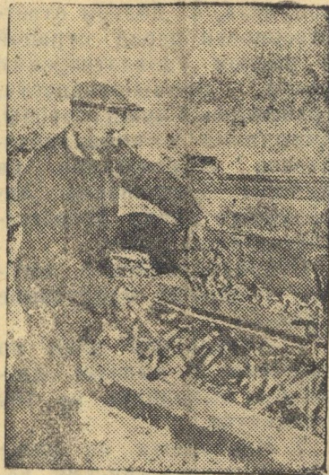
Кузнец-стахановец Чуйской МТС П. Н. Иконописцев, имеющий 40 лет производственного стажа, ремонтирует сеялку. Тов. Иконописцев производит ремонт только на „отлично“.
