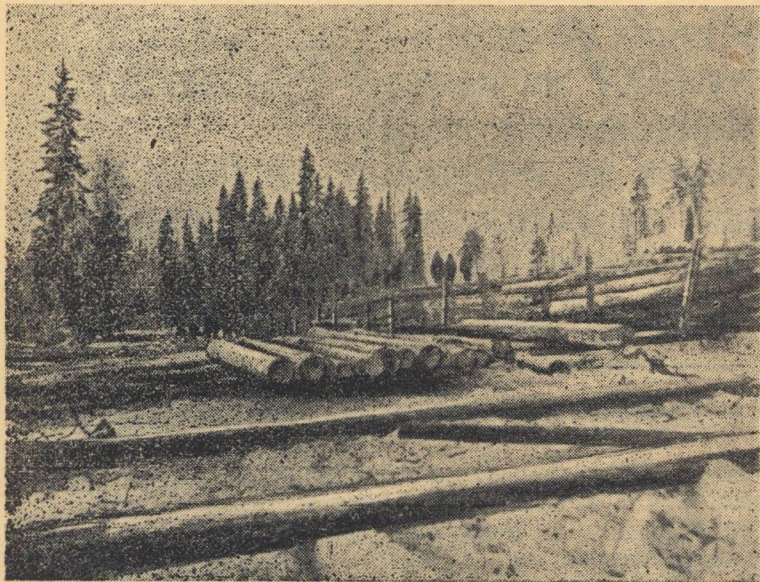
Погрузочно-разгрузочная эстакада Ужельского механизированного лесопункта.
