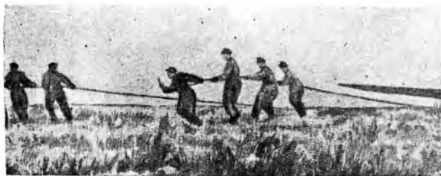
Фиг. 101. Запуск планера. Команда натягивает амортизатор.
