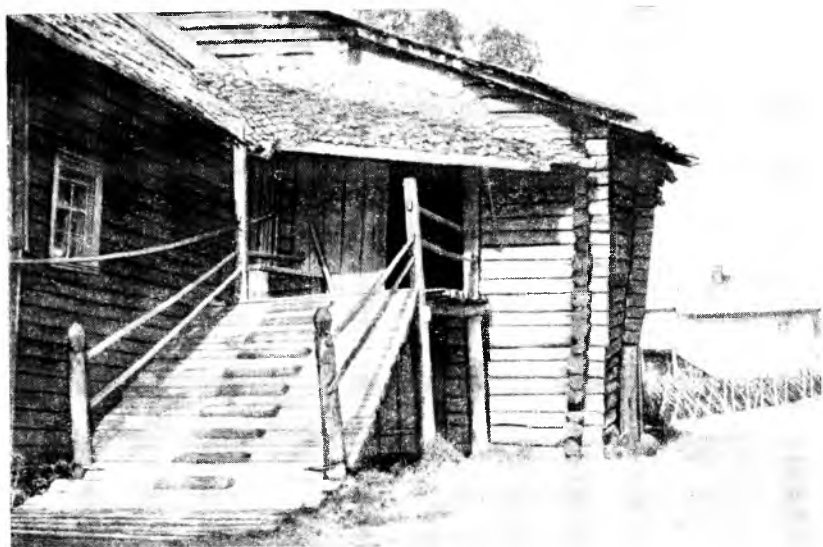
Рис. 19. Вход в дом по взвозу.
