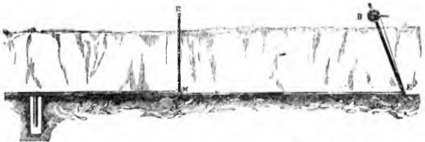
Фиг. 6 — Выниманіе полосы изъ водопроводныхъ трубъ, по укладкѣ ихъ на мѣсто во рву
