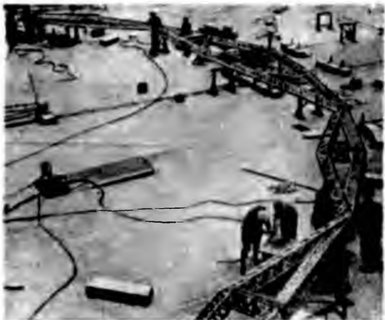
Фиг. 75. Монтаж шпангоута на полу эллинга.
