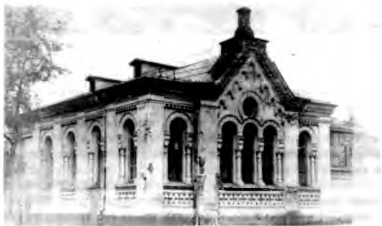
Ил. 11. Церковь Николо-Корельского подворья. 1904 г. Фото 1980-х г.
