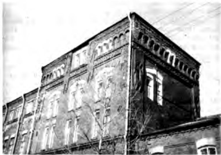
Ил. 14. Казенные винные склады. Фрагмент юго-западного фасада. Фото И. Дейнеко. 1991 г.
