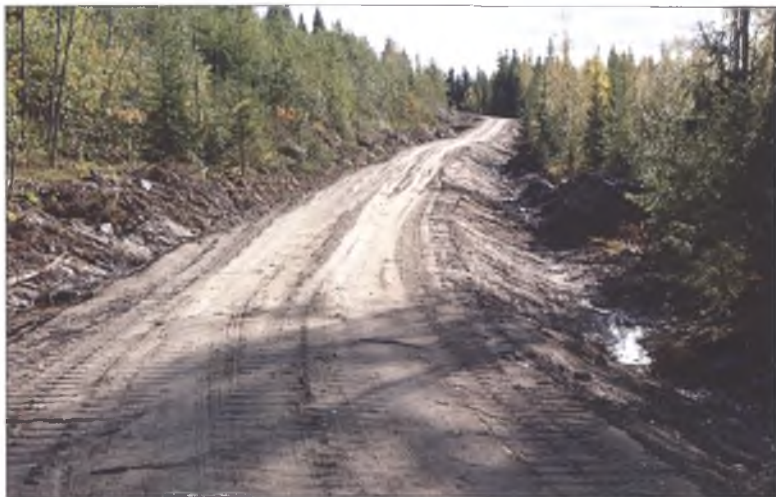
Рис. 15. Прежде чем начнется строительство покрытия и непосредственно эксплуатация, основанию строящегося уса дают в течение зимы уплотниться
