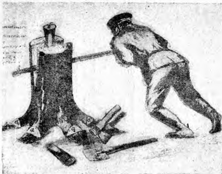
1. Корчевка пня ручным способом
