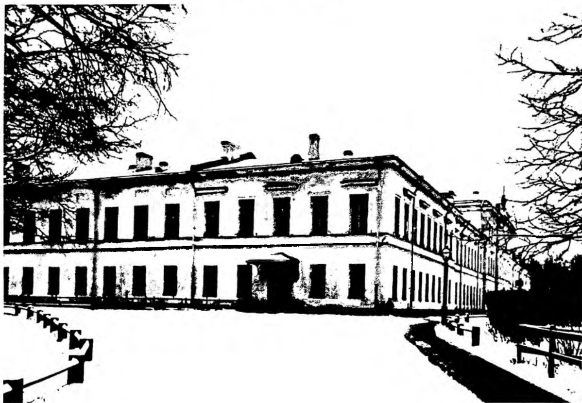
Главное здание Лесного института с юго-запада
