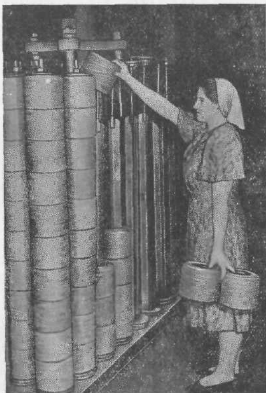
Рис. 28. Надевание бобин на стержни бобино-держателя
