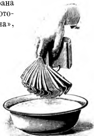
Рис. 66. Чистка барабанной вставки сепараторовъ «Пумпъ».
