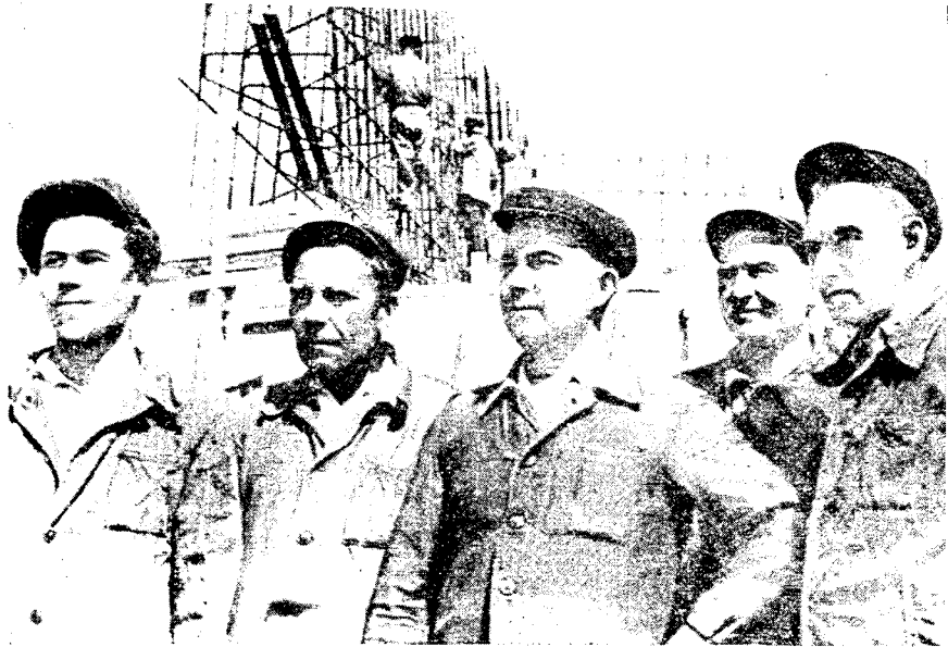
Они строят Волго-Балт. На снимке: бригада бетонщиков А. П. Степанова, работающая на Череповецком гидроузле.
