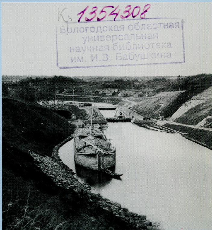
Шлюз №26 (Св. Андрея) с плотиной. Д. Великий Двор.
