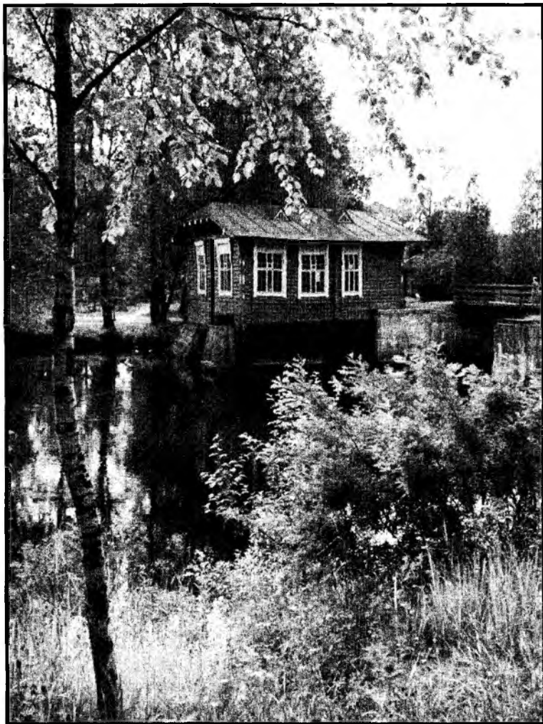
Машинный зал ГЭС на плотине Вытегорского гидроузла - здание музея "Водные пути Севера". 2005 год.
