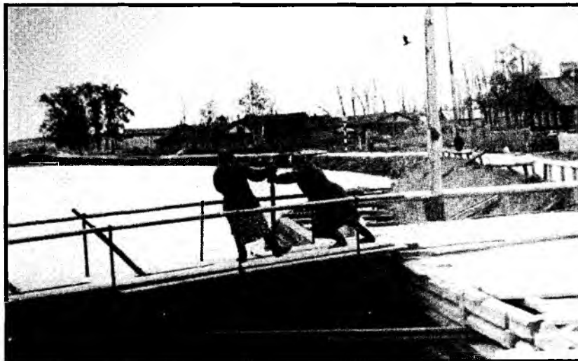
Открытие водопропускных отверстий в нижних воротах шлюза для опорожнения камеры. Шлюз № 31 Св. Анны. 1954 год.
