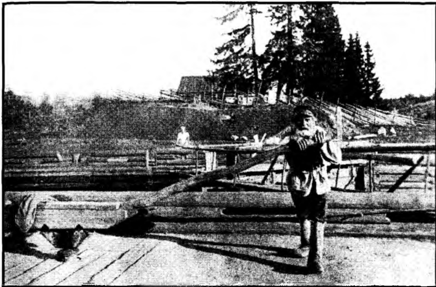
Механизм открытия ворот деревянного шлюза. 1896 год.
