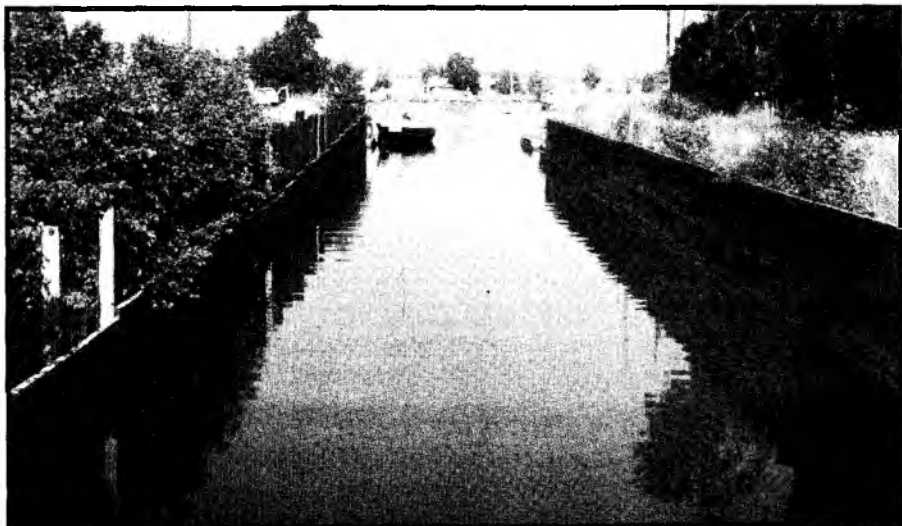
Шлюз Св. Сергия в 2004 году через 9 лет после прекращения ремонтных работ.
