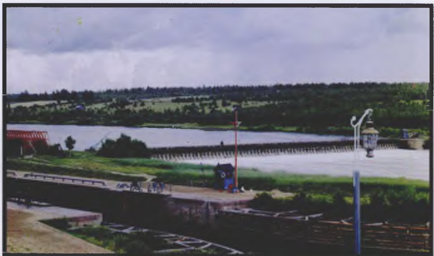
Шлюз и плотина императора Николая II (у д. Чёрная Гряда). 1909 год.
