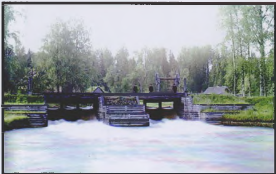
Ковжская плотина, регулирующая питание соединительного канала из Ковжского водохранилища (озера). 1909 год.
