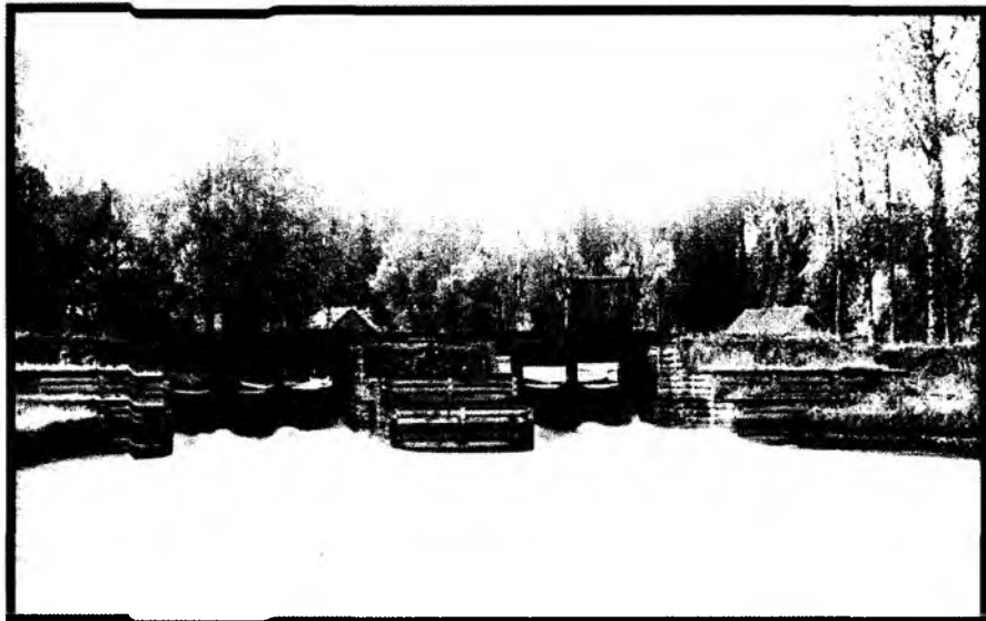
Ковжская плотина, регулирующая питание соединительного канала из Ковжского водохранилища (озера).
