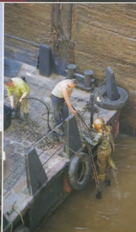
▲ Водолазные работы в камере шлюза № 5
