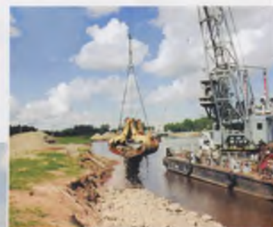
▼ Завершение работ по расширению судоходной трассы верхнего подходного канала шлюза № 5 земснарядом СЗ-209, 2004 г.
