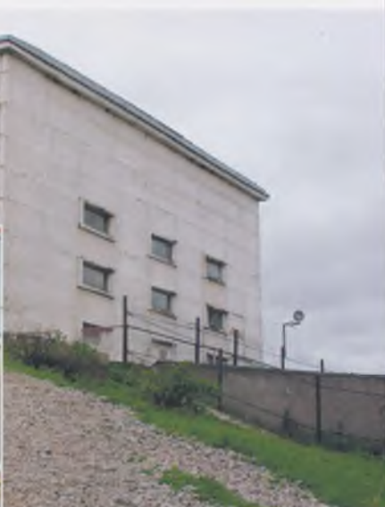
▲ ГЭС-31, г. Вытегра.
