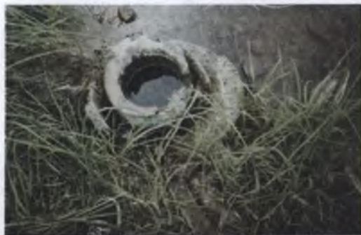
Рис. 19. Рассолоподъемная труба
