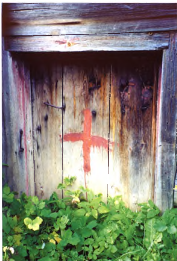
Дверь в подвал дома А. Д. Клементьевой (д. Пожарище Нюксенского р-на)
