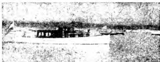
Рис. 61. — Бензино-электрическая моторная яхта 12,6 метра длины; 2,4 м. наибольшей ширины, съ бензиновымъ двигателемъ въ 35 л. с. Аккумуляторы вѣсятъ 500 килограммовъ, и при нормальной разрядкѣ даютъ около 8 километровъ въ часъ. Построена заводомъ Сименс .
