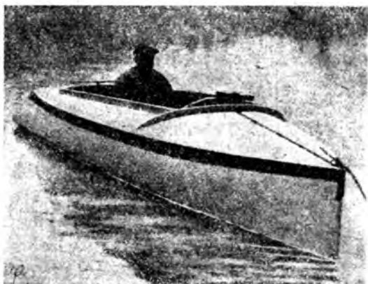
Рис. 37.—Наружный видъ гоночной лодки небольшихъ размѣровъ, 8 метровъ, двигатель 24 л. с. Форма передней части корпуса приспособлена для наименьшаго сопротивленія не только воды, но и воздуха.
