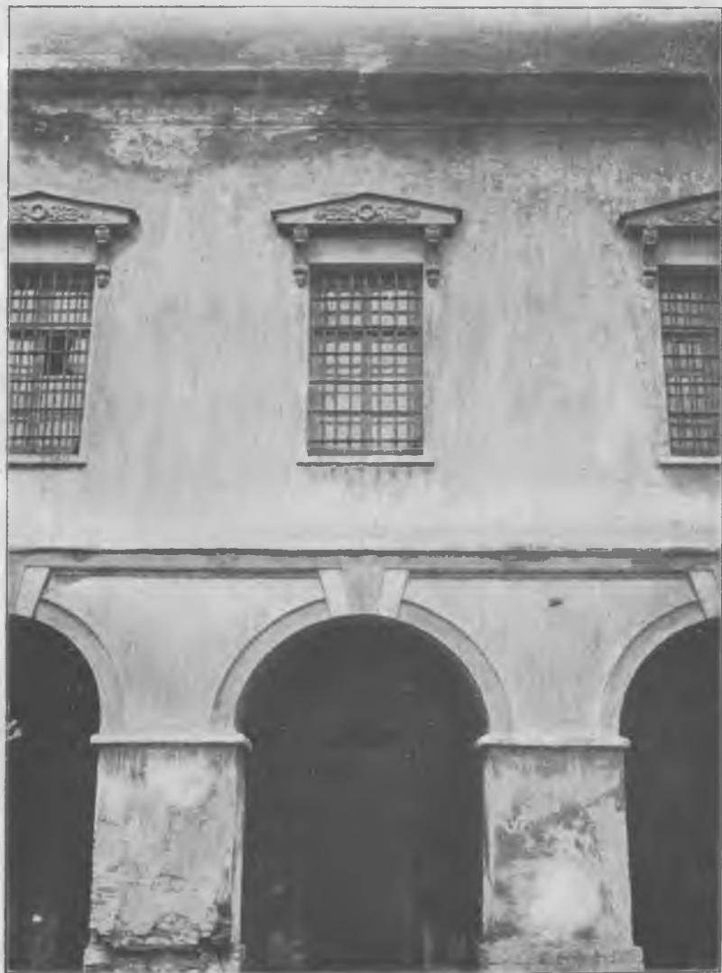
Часть аркады Старого Гостиного Двора (сломана).
