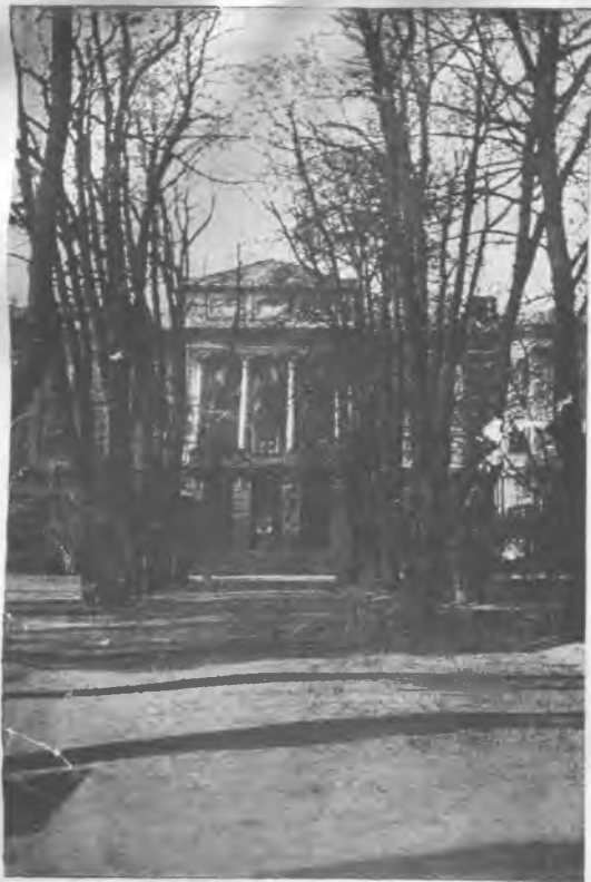
Фасадъ Николаевскаго Сиротскаго Института со стороны сада.
