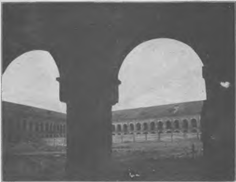
Дворъ Старого Гостиннаго Двора (начало сломки).
