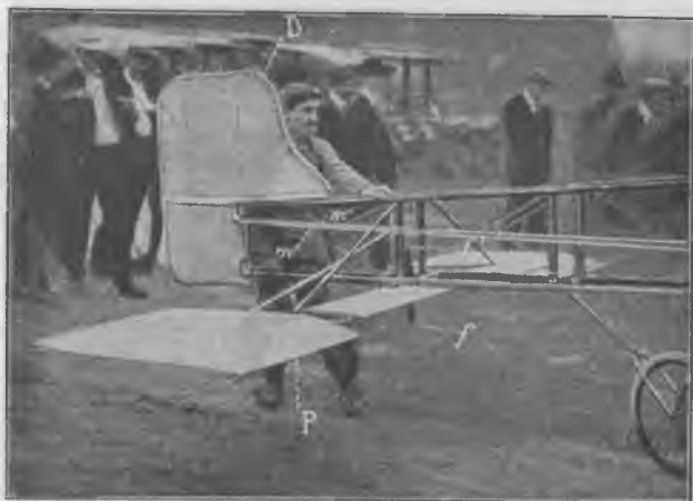
Рис. 15. Хвостъ устойчивости аэроплана Блеріо.
