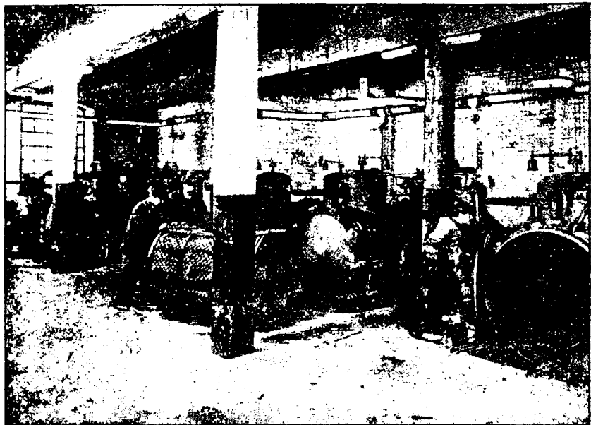
Рис. 173. Завод системы Пэфайи. Мочильные котлы.
