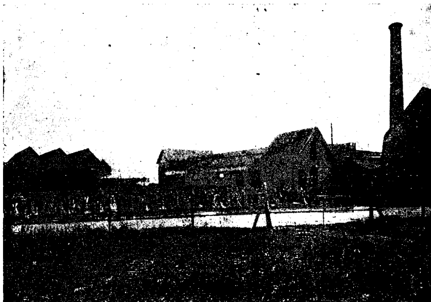
Рис. 154. Льнообделочный завод Ванстенкиста в Вевельгеме (Бельгия), построенный в 1905 г. (в глубине, справа, видно мочильное отделение; слева — сараи; спереди — трепальное отделение).
