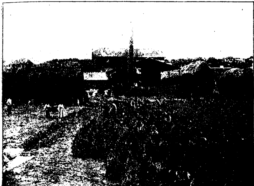
Рис. 163. Завод в Боннетабле. Естественная сушка.
