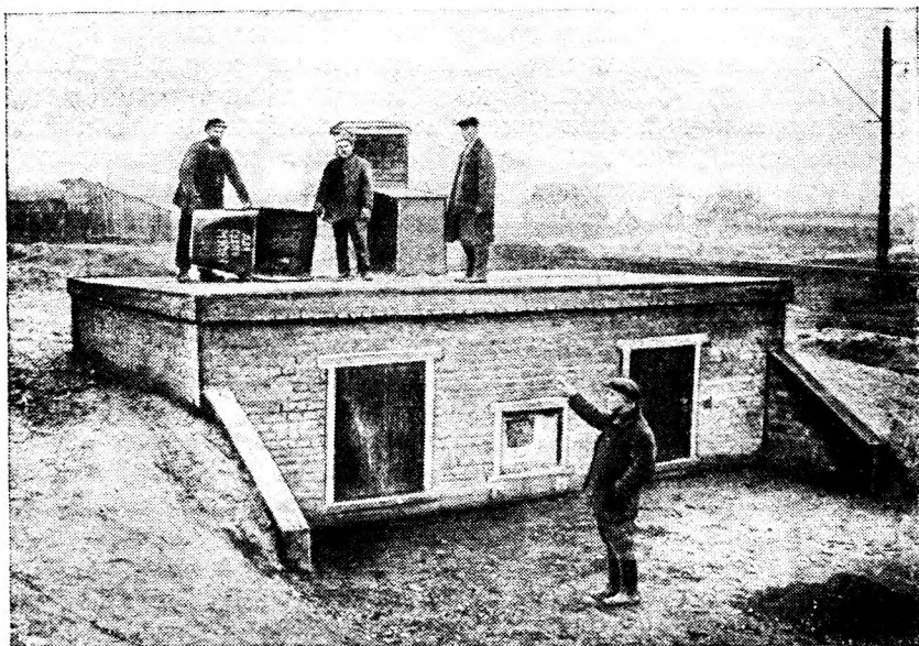
Рис. 1. Момент загрузки мусора в камеру через люк в потолке. На фасадной стене видны двери для выгрузки мусора
