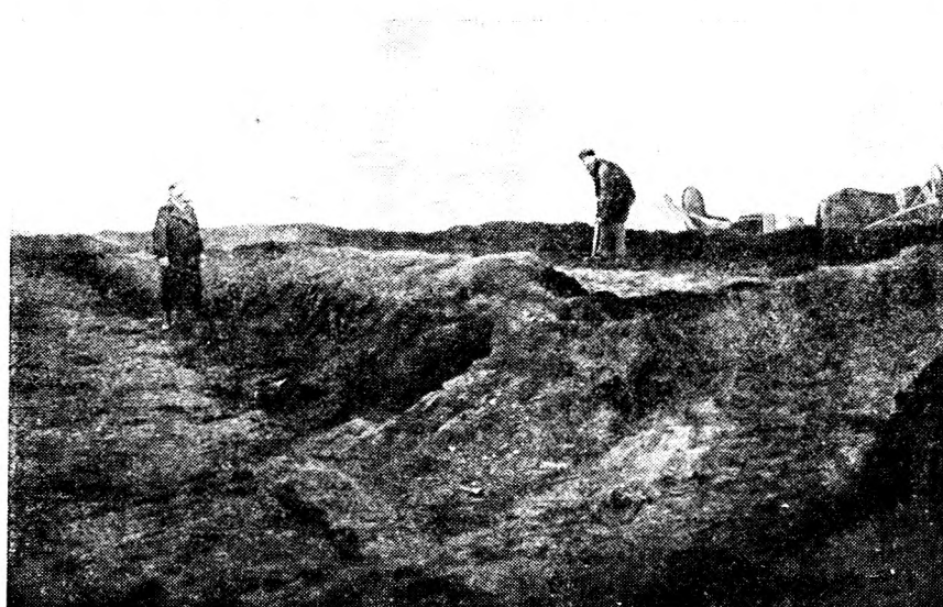
Рис. 4. Один из вариантов наземного компостирования. Момент заливки торфа нечистотами (засыпка будет производиться торфом из валов)
