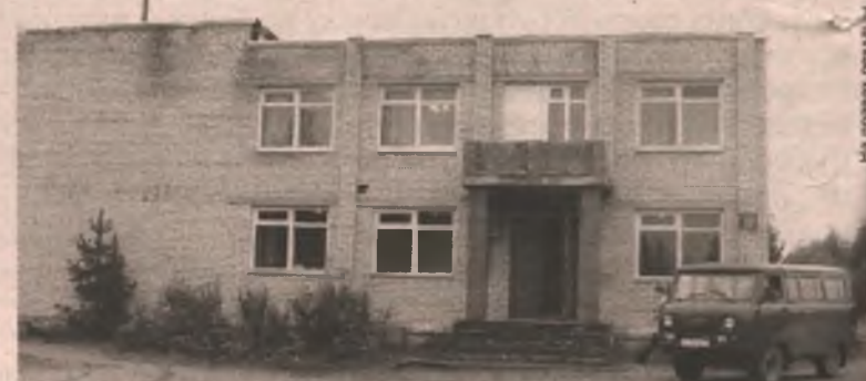
Здание Бабаевского лесхоза.
