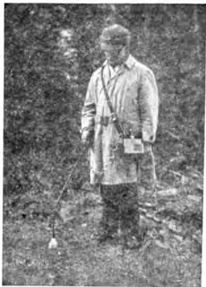
Рис. 15. Инфракрасный прибор для обнаружения «скрытых» очагов горения
