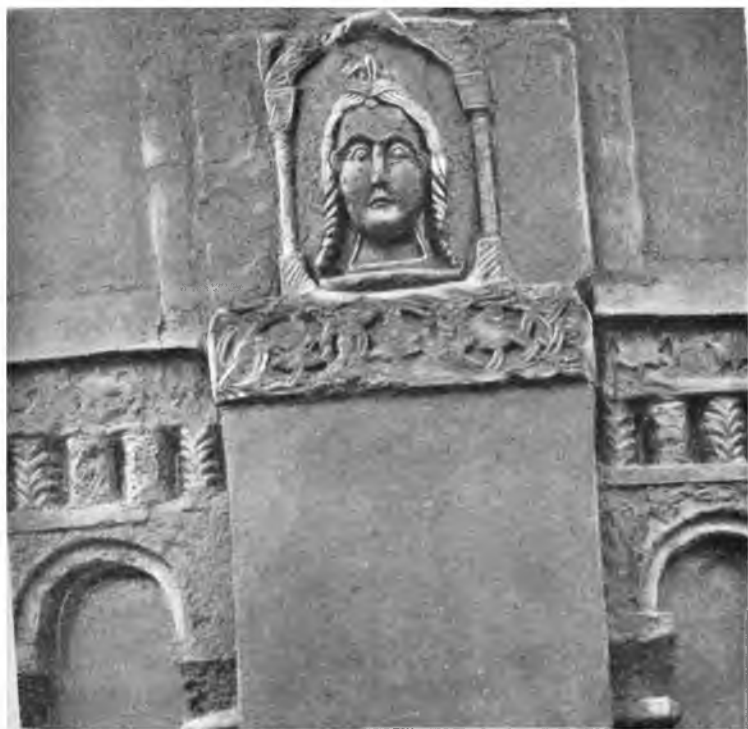
Рис. 39. Суздальский собор. Деталь фасада.
