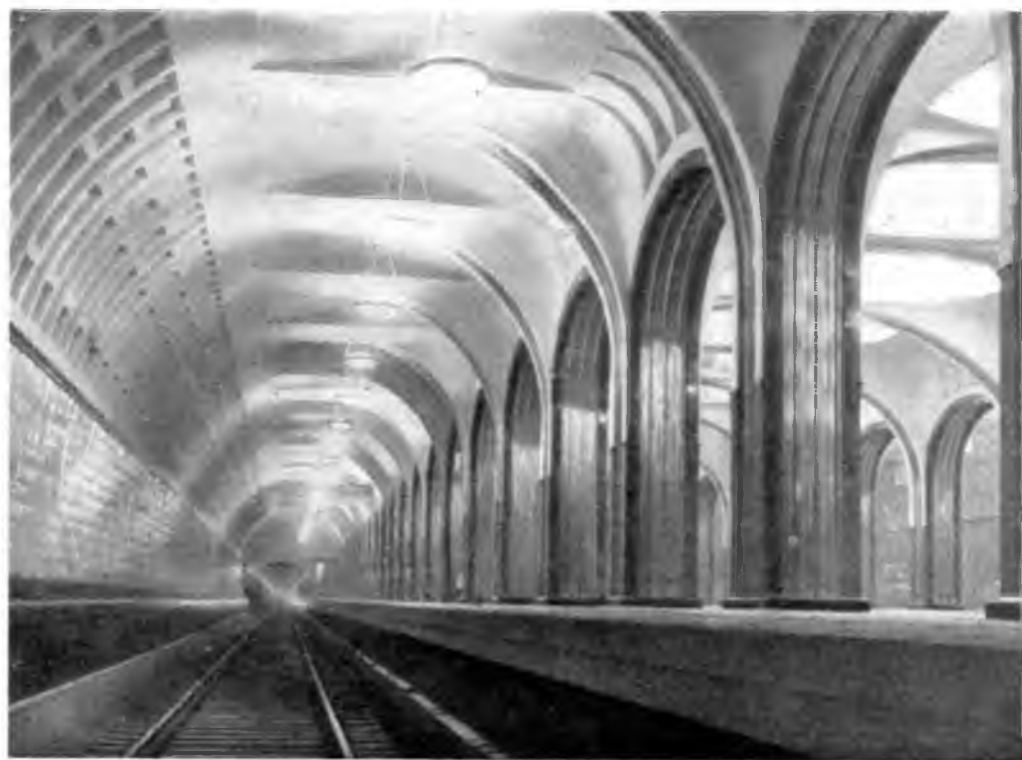
52. Станция „Маяковская“. Перрон. Арх. А. Н. Душкин
