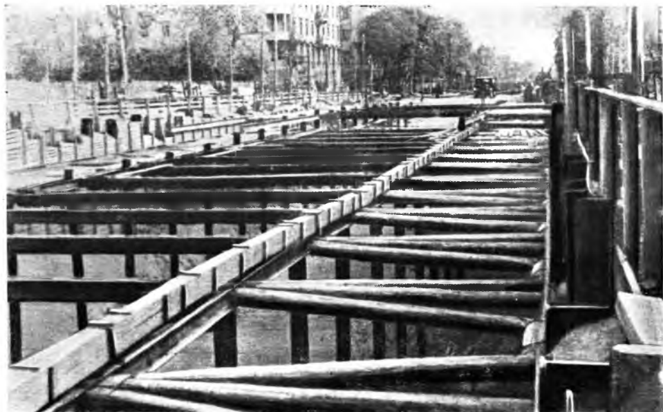
18. Общий вид крепления в открытом котловане
