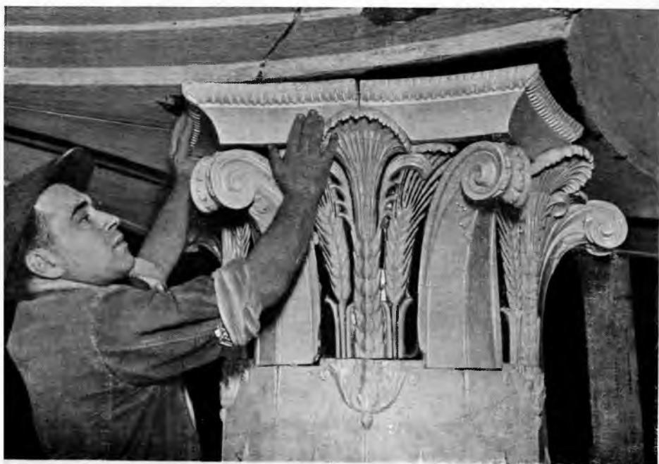
16. Станция „Киевская“. Установка фарфоровой капители
