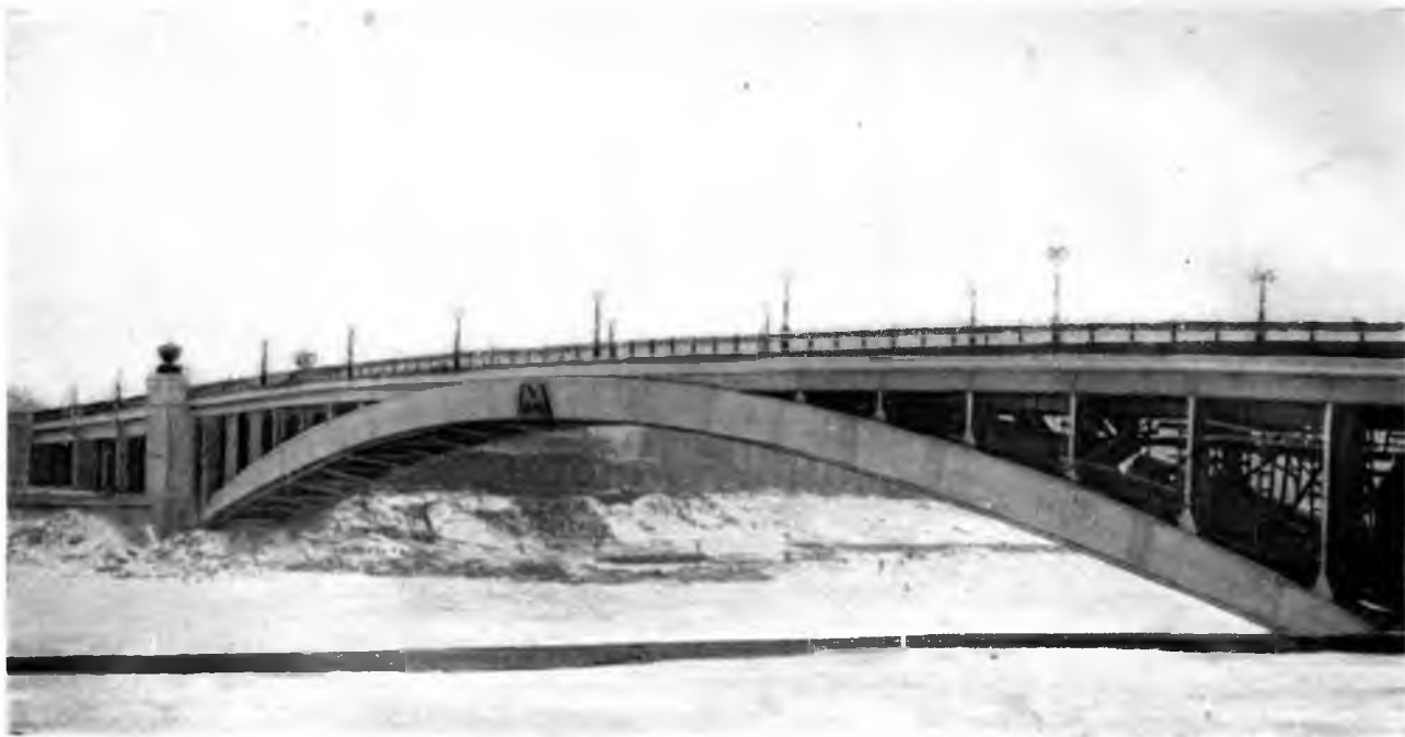
9. Мост метро. Архитекторы К. Н. и Ю. Н. Яковлевы
