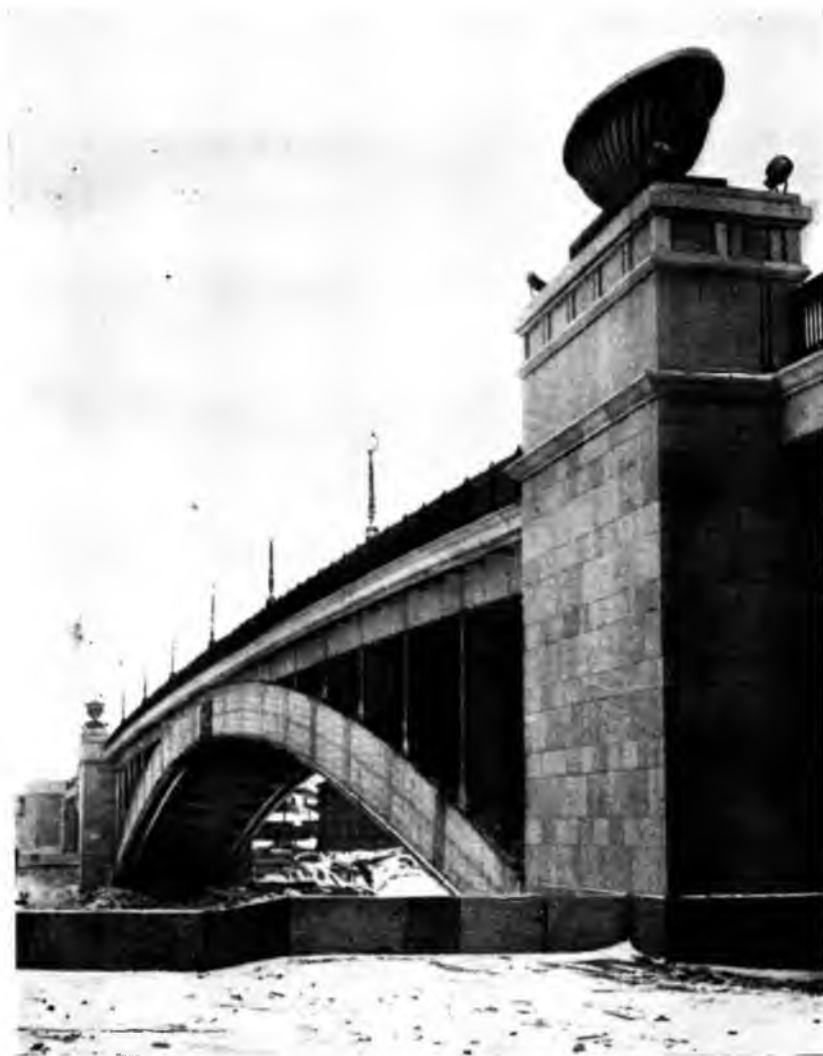
8. Мост метро. Архитекторы К. Н. и Ю. Н. Яковлевы
