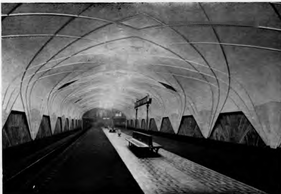
7. Станционный зал станции „Аэропорт“. Архитекторы Б. С. Виленский, В. А. Ершов
