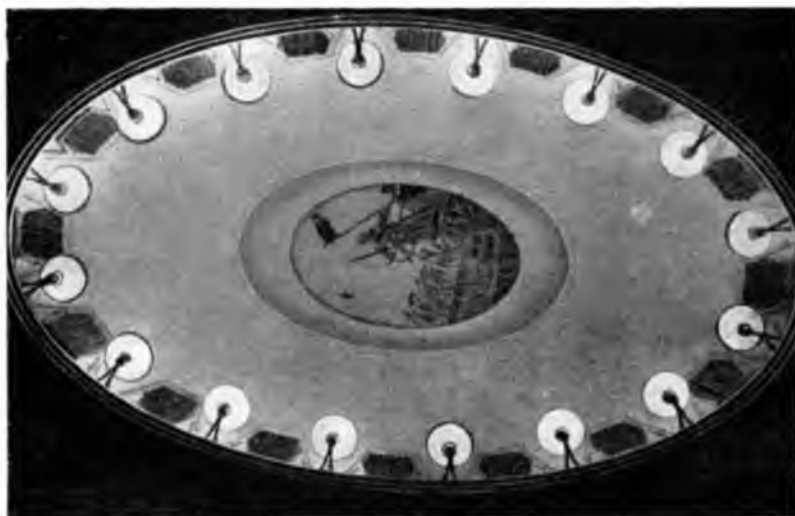
54. Станция „Маяковская“. Фрагмент купола. Арх. А. Н. Душкин, художник А. А. Дейнека
