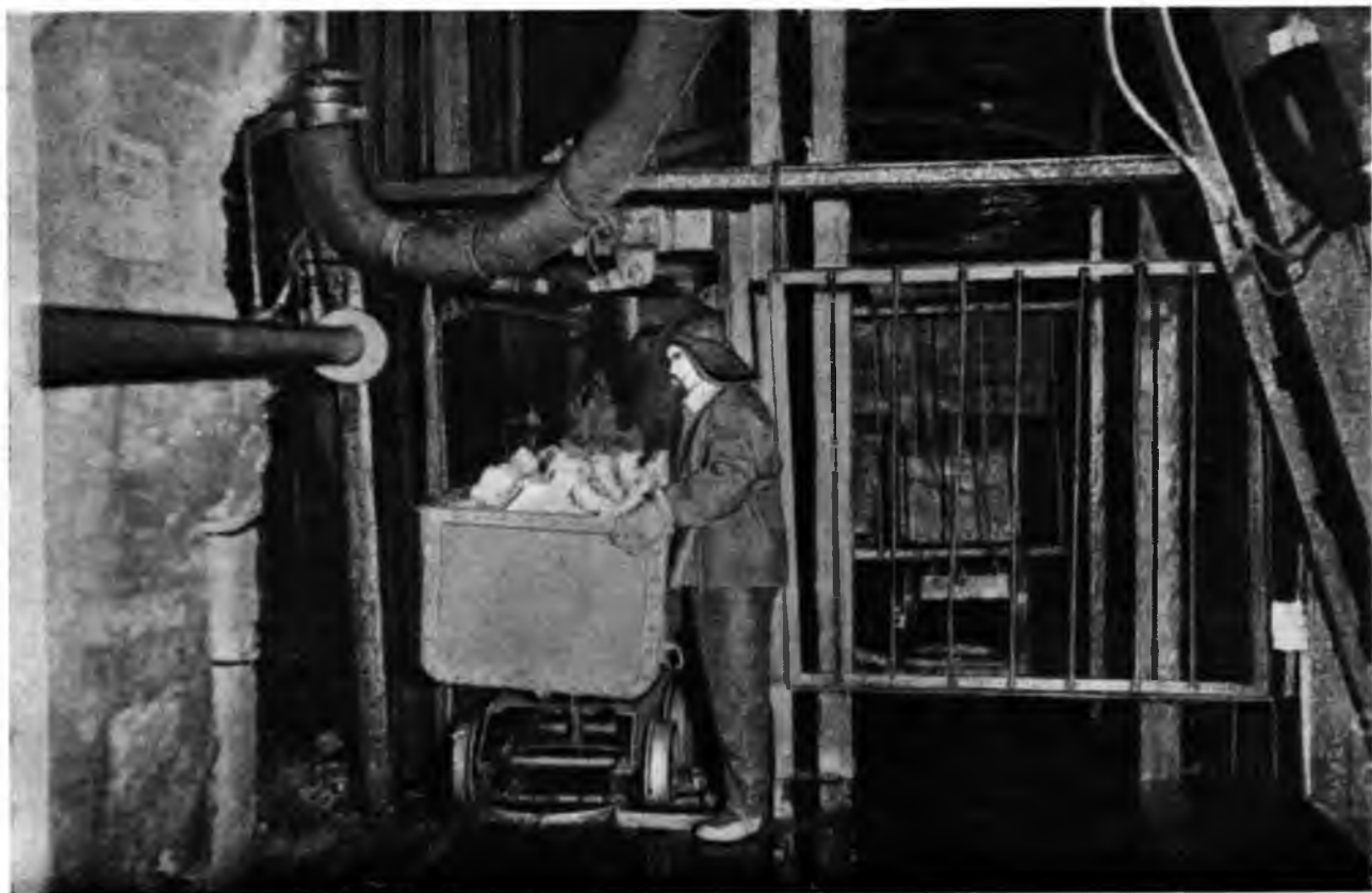
9. Подача породы в шахтный ствол
