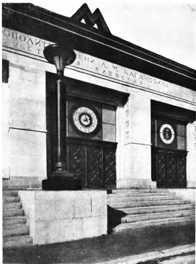
36. Облицовка фасада вестибюля станции „Киевская“. Арх. Д. Н. Чечулин
