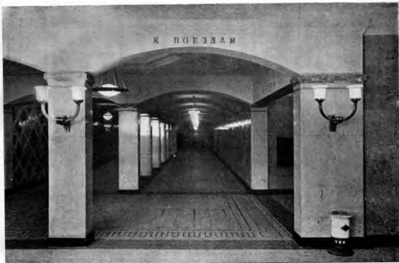
94. Станция „Сокол“. Подземный переход. Архитекторы К. Н. и Ю. Н. Яковлевы
