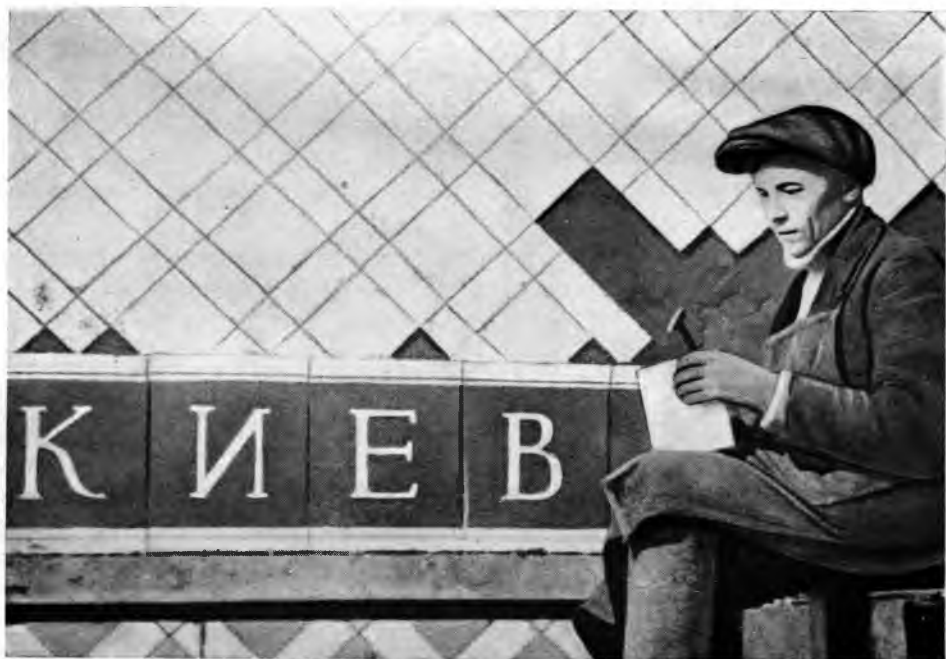
17. Станция „Киевская“. Установка керамической плитки
