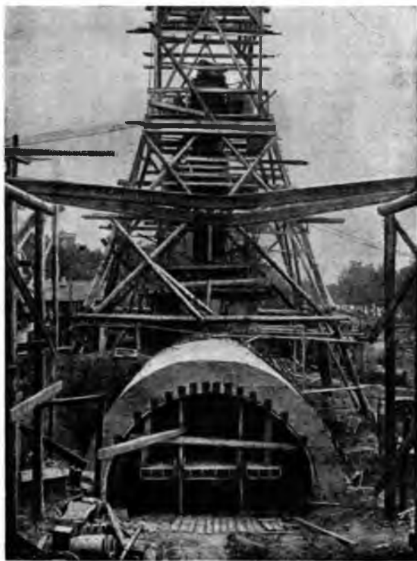
13. Опускание кессона-тоннеля
