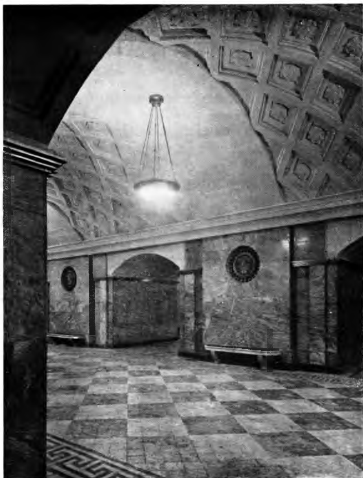
38. Цементные кессоны сводов станции „Курская“. Арх. Л. М. Поляков
