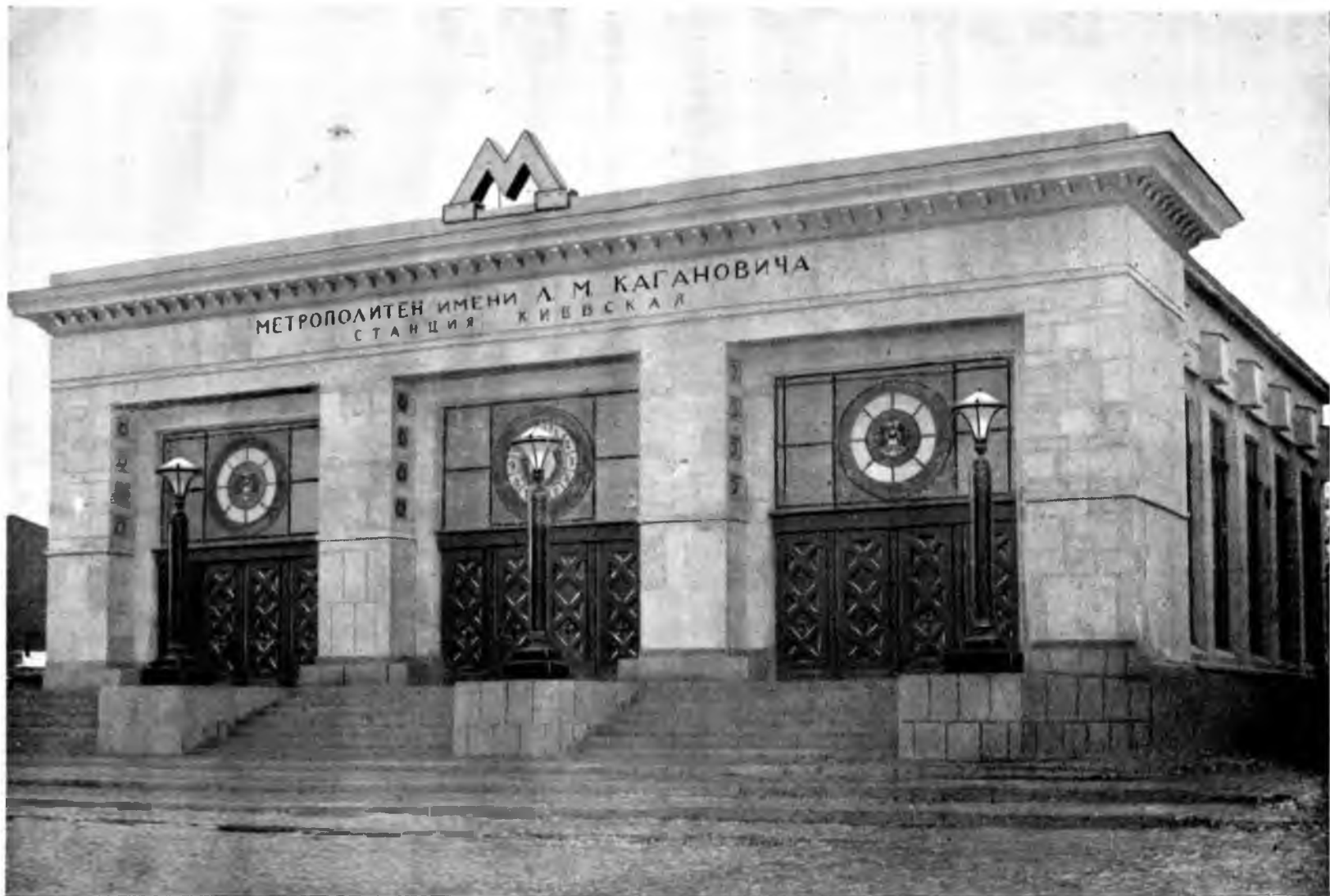
24. Станция „Киевская“. Фасад вестибюля. Арх. Д. Н. Чечулин
