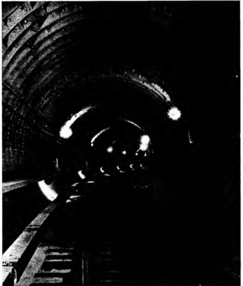
1. Вид тоннеля, сложенного из чугунных тубингов
