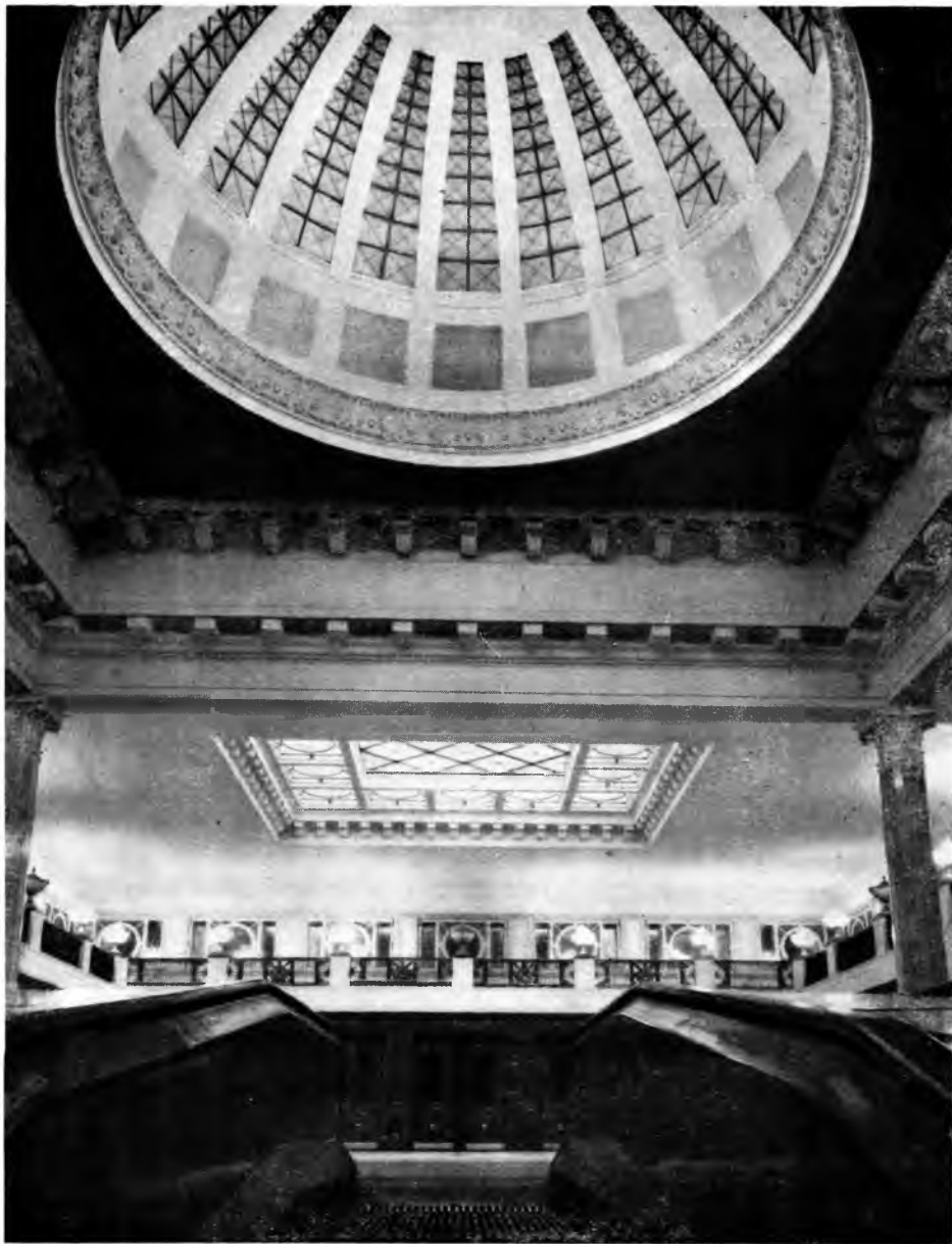
33. Вестибюль станции „Динамо“. Купола и световые фонари. Арх. Д. Н. Чечулин
