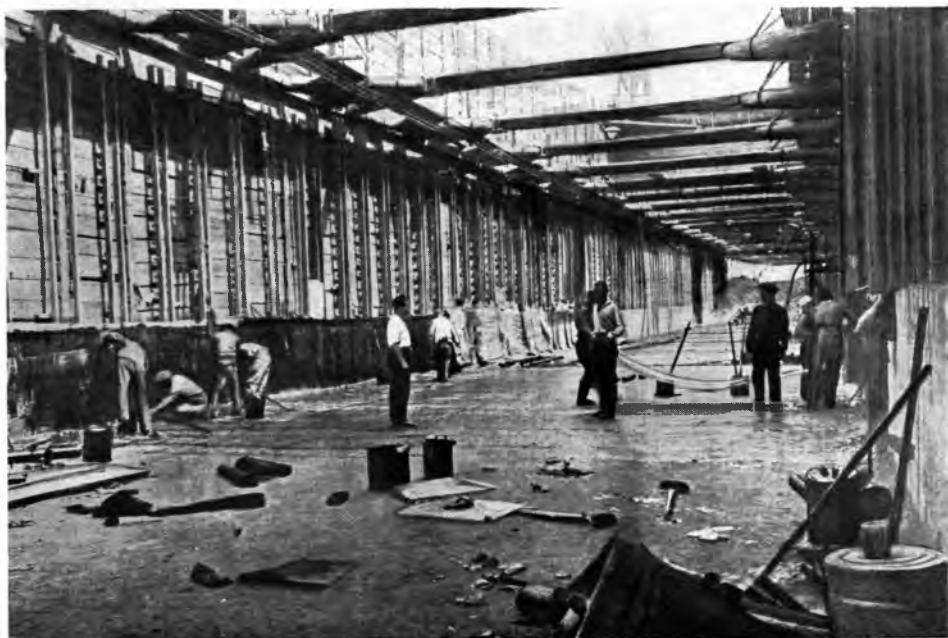
19. Изоляционные работы в котловане
