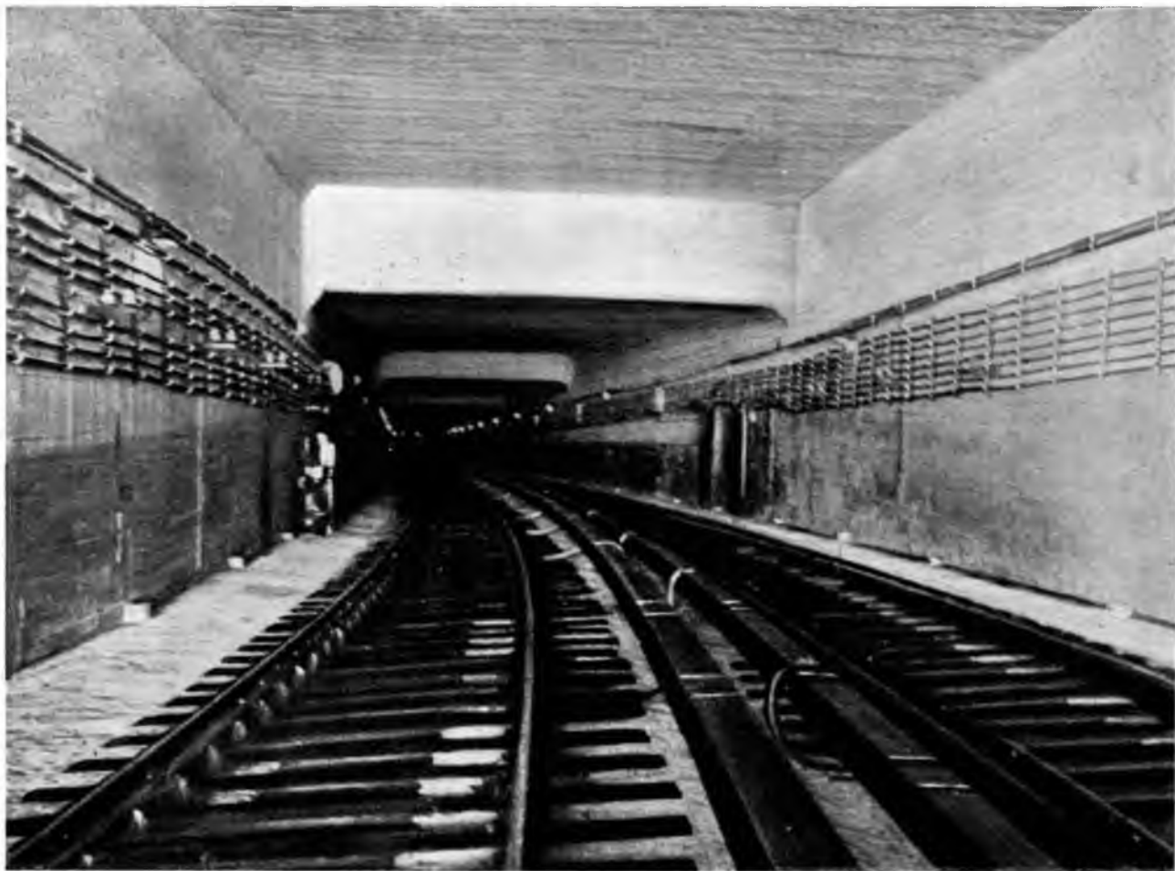
2. Перегонный тоннель мелкого заложения
