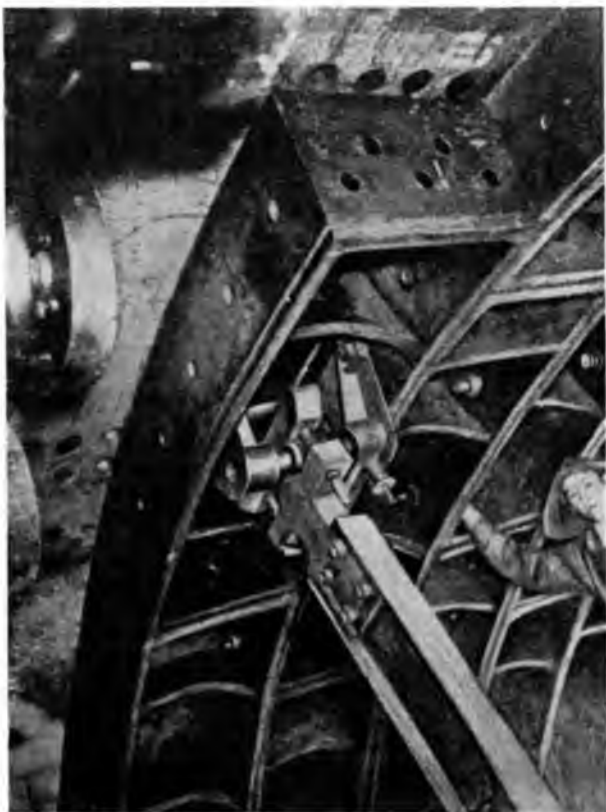
12. Захват тюбинга при монтаже
