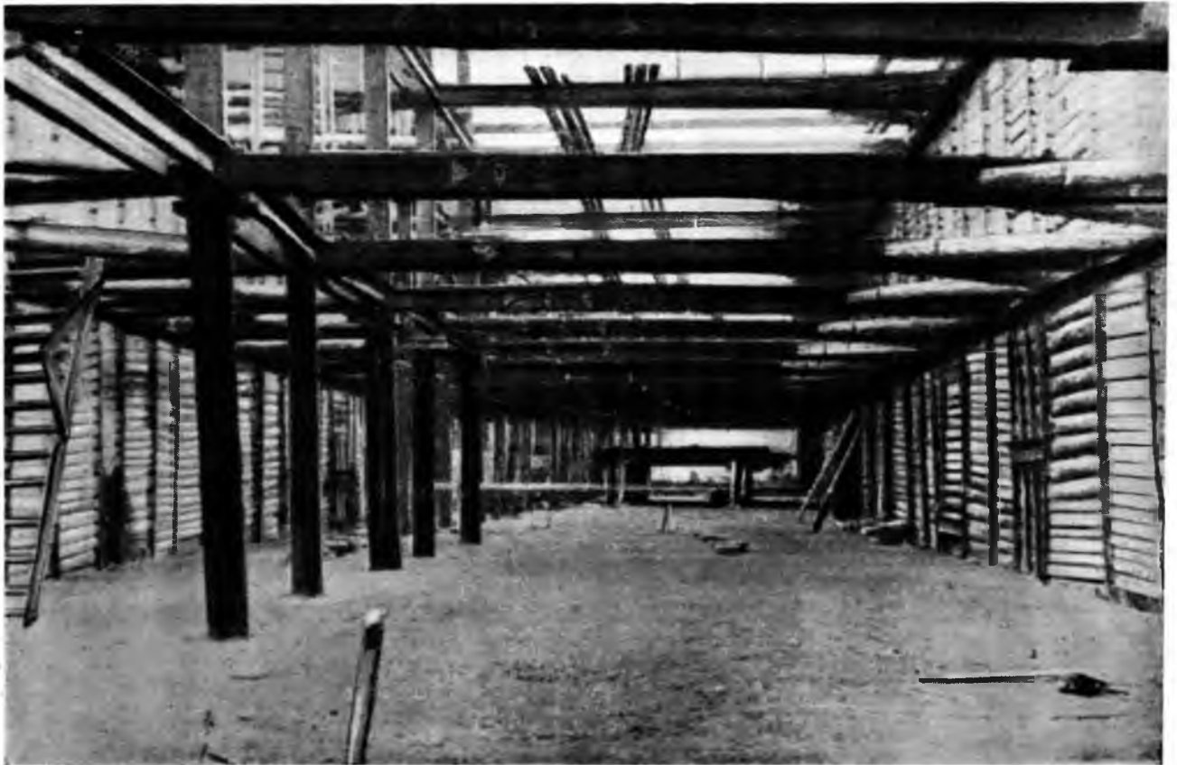
6. Раскрепленный котлован при открытом способе работ
