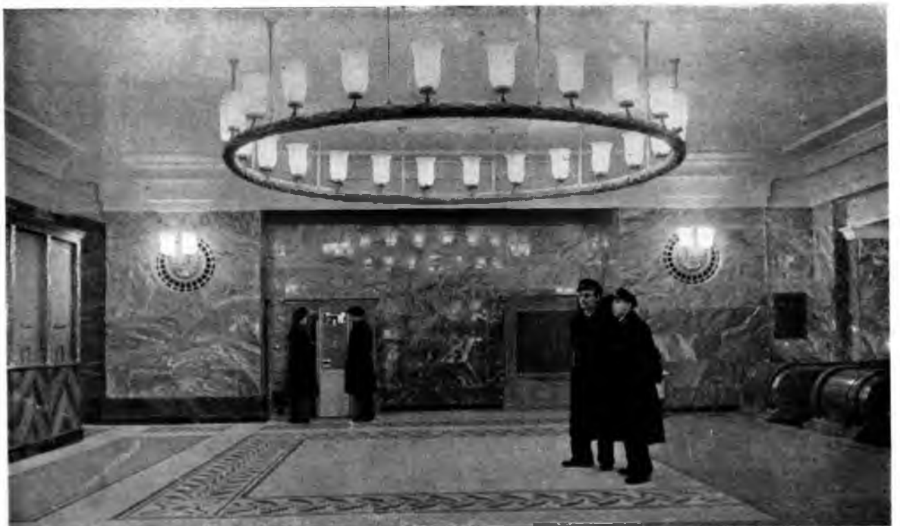
42. Станция „Курская“. Наземный эскалаторный зал. Арх. Л. М. Поляков
