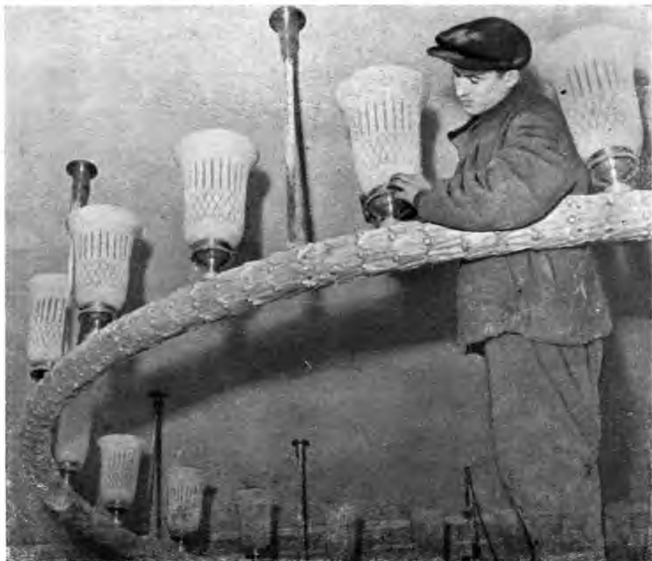
30. Монтаж люстры в кассовом зале станции „Курская“
