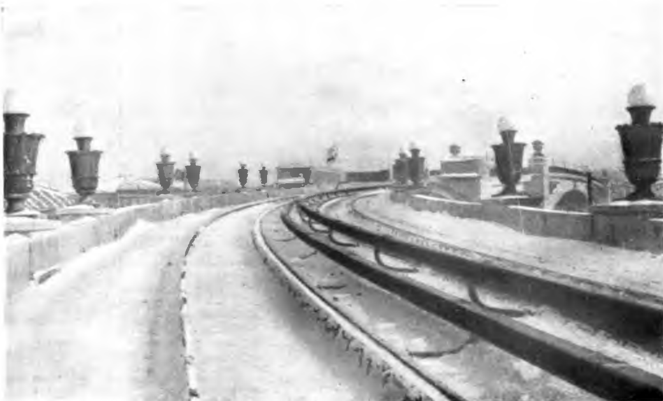
10. Эстакада моста метро. Архитекторы К. Н. и Ю. Н. Яковлевы
