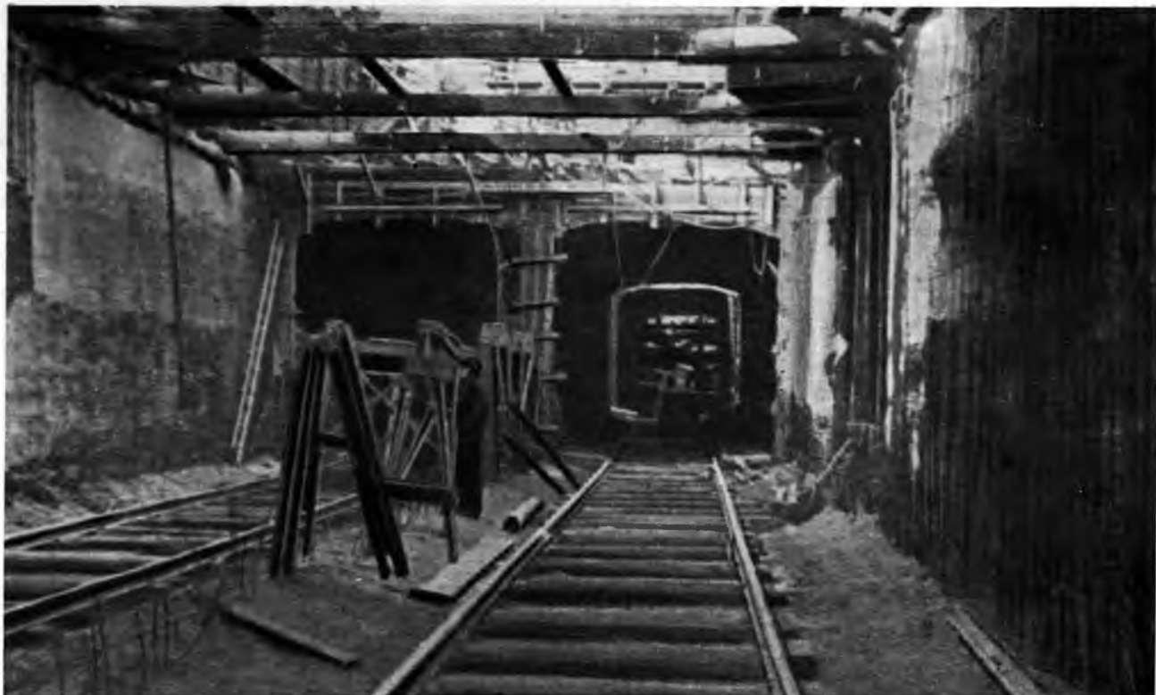
20. Подвижная металлическая опалубка
