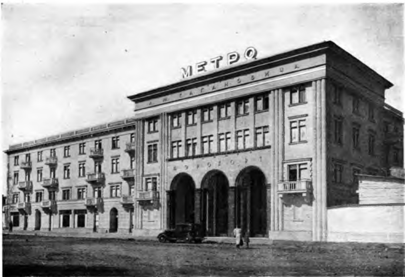
85. Вестибюль станции «Аэропорт». Арх. С. М. Кравец
