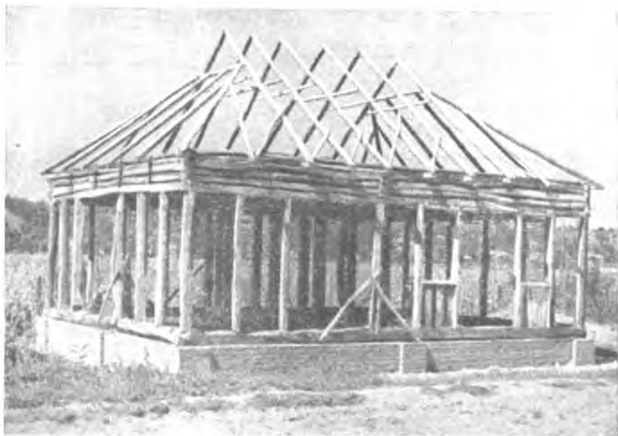
49. Конструктивный скелет каркасной хаты. Село Засулье. Полтавщина.
