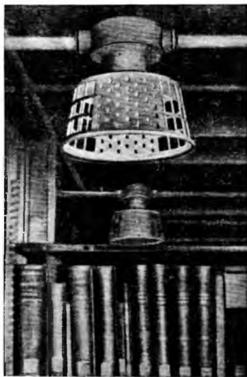
219. Специальный светильник фирмы „Snead“ для освещения книгохранилищ
