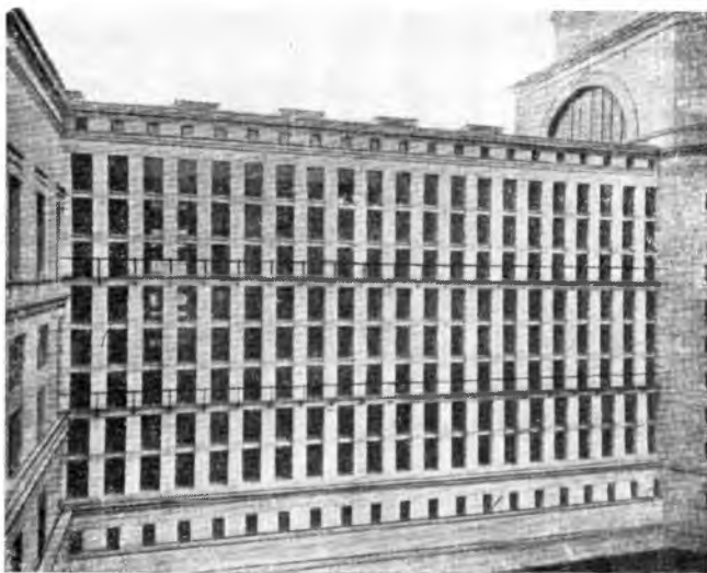
69. Внешний вид корпуса книгохранилища библиотеки Конгресса в Вашингтоне
