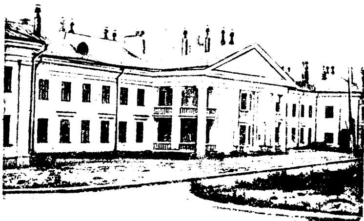
Новая инфекционная больница в Череповце.
